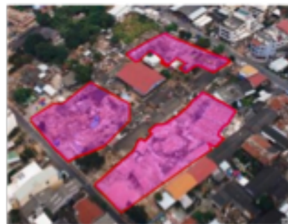
圖 10、UAV 影像辨識房舍倒塌範圍
