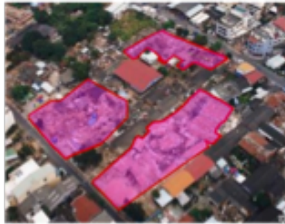
圖 10、UAV 影像辨識房舍倒塌範圍
